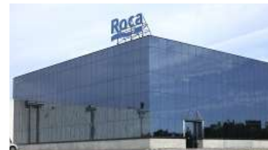
Завод ООО «Рока Рус» заказчик ООО СУ «Стиль-М»
